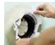
Natte d'étanchéité prémontée
