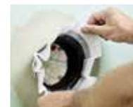
Natte d'étanchéité prémontée
